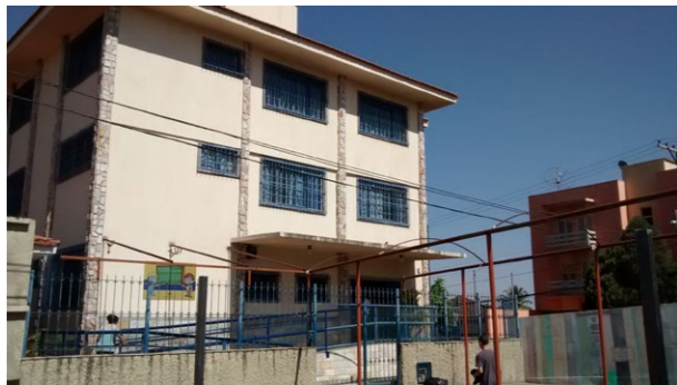
Figura 2: Entrada da Unidade II da Escola Municipal Uberaba. K. F. Amaral, 2015.
